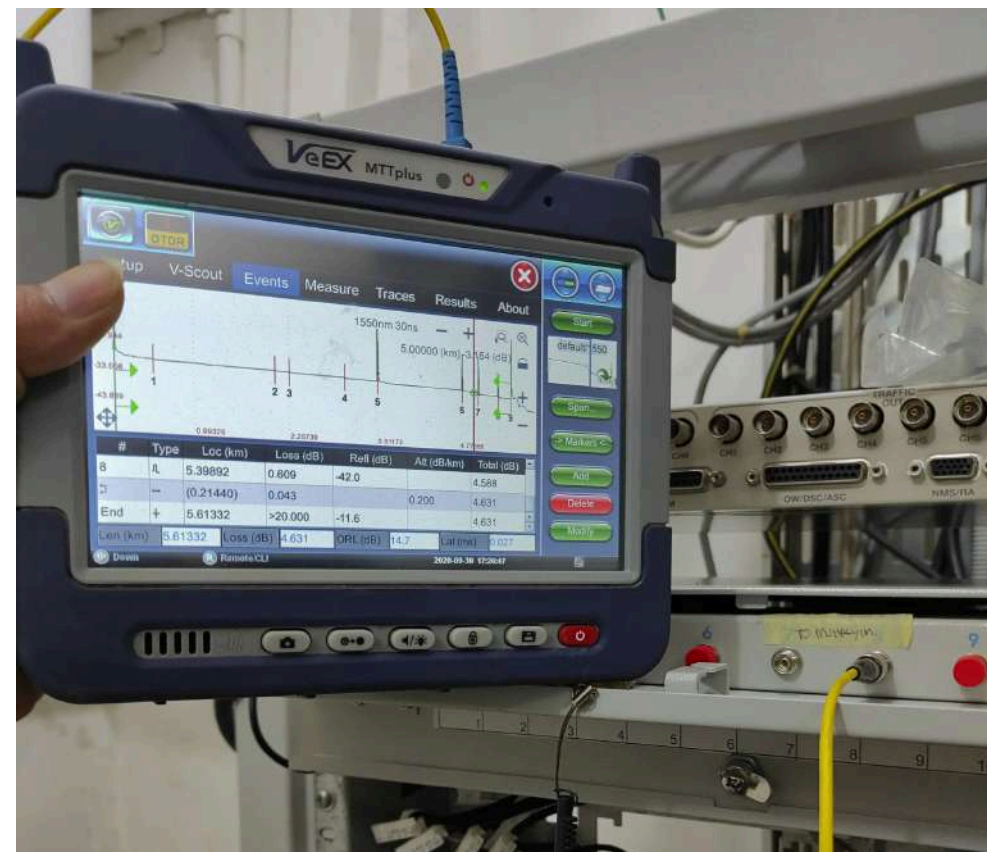
Pengukuran Ujung ke Ujung Kabel Fiber Optik
