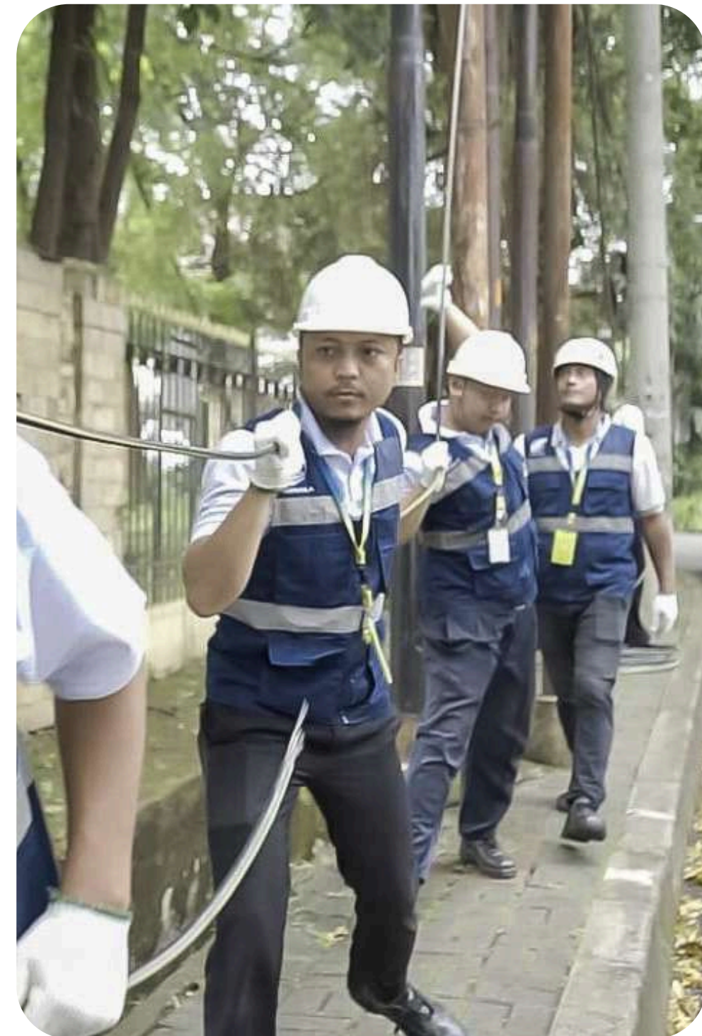
Pekerjaan Sipil Penarikan Kabel Fiber Optik
